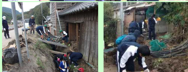
▲民家に入り込んだ多量の土砂を運び出す生徒達
